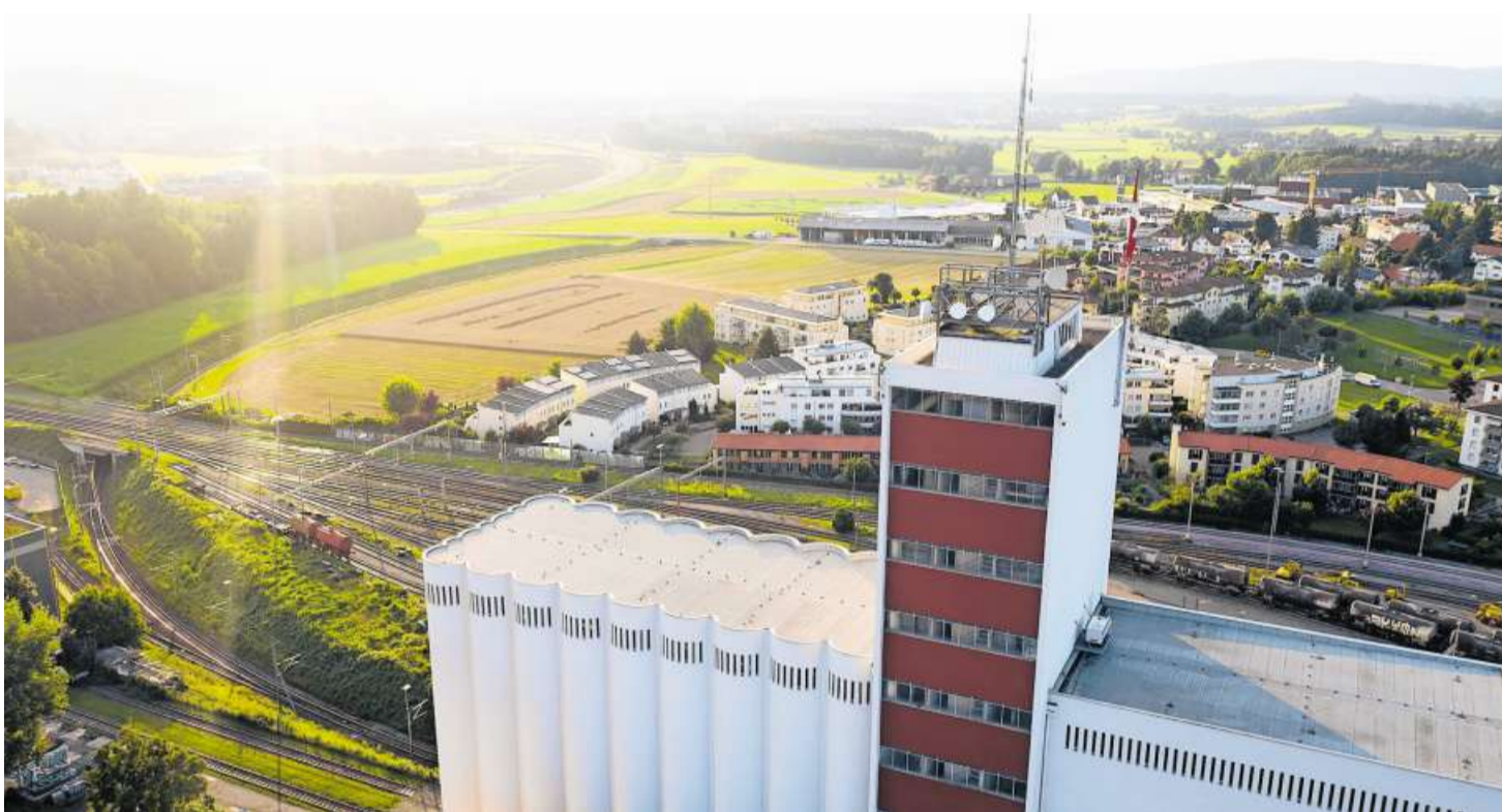
Der westliche Stadtrand von Wil. Links im Bild das umstrittene Gelände.
