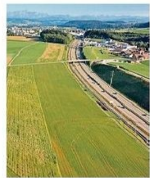
Ein Teil des Gebietes, das durch den ESP Wil West erschlossen werden soll.
