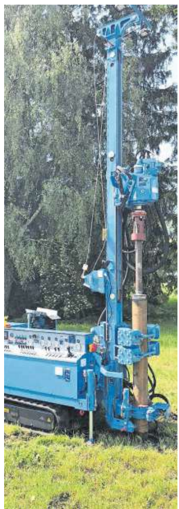
Ein Teil der Kernbohrungen wird mit einem Raupenbohrgerät ausgeführt. Bild: PD
