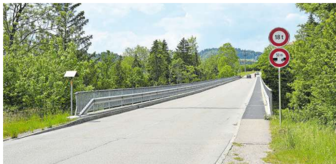
Von der Gewichtsbeschränkung auf der Letzibrücke ist auch der Nachtbus betroffen. Bild: Beat Lanzendorfer
